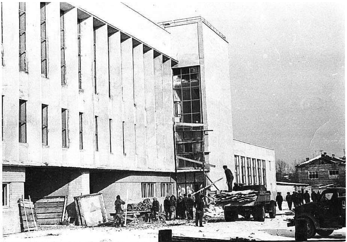
Будівництво гуманітарного корпусу (бібліотека, актовий зал), де працювали студентські будівельні бригади. 1966 р.
