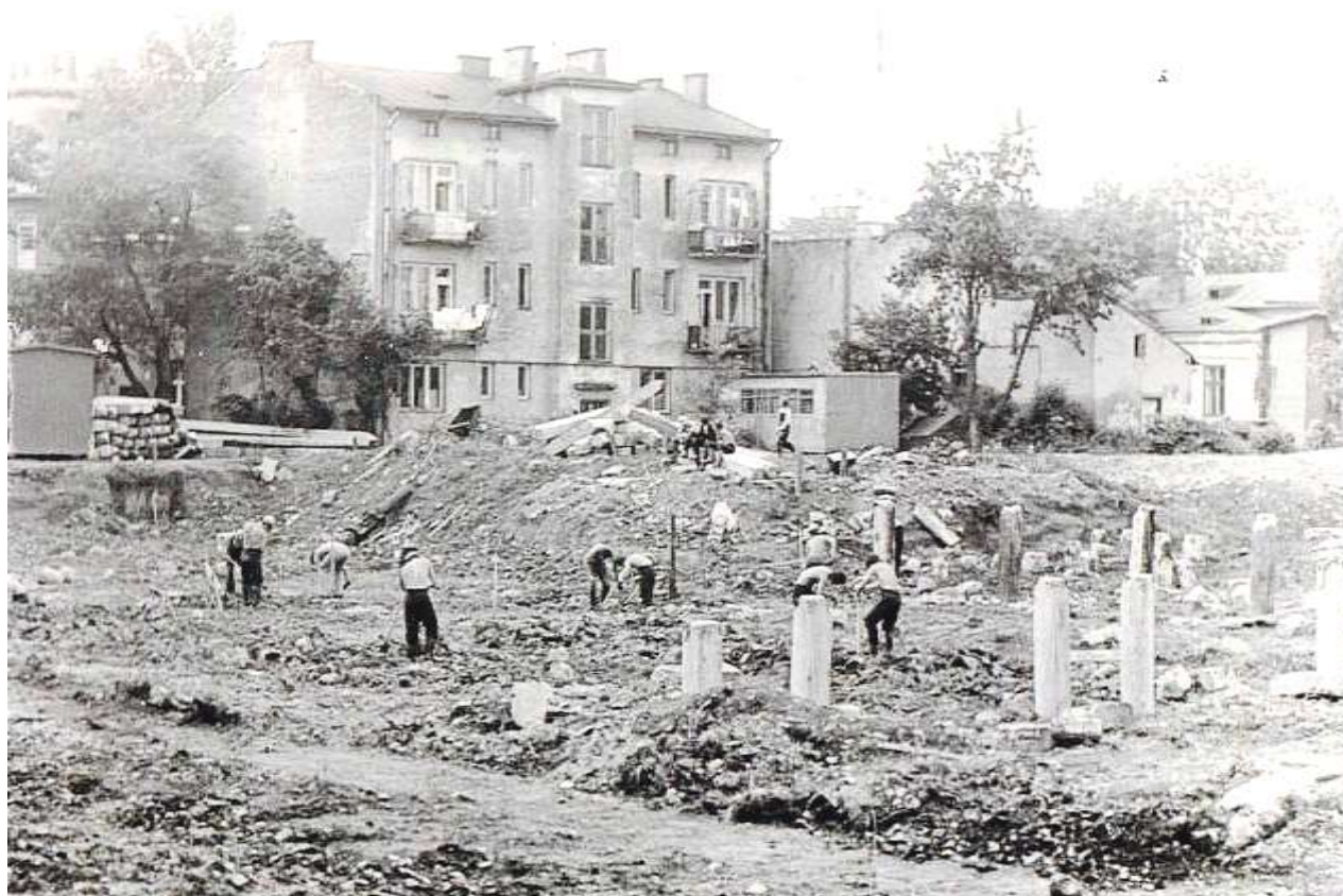
Будівельний загін студентів пединституту ім. С.А. Ковпака працює на будівництві нового корпусу. 1964 р.
